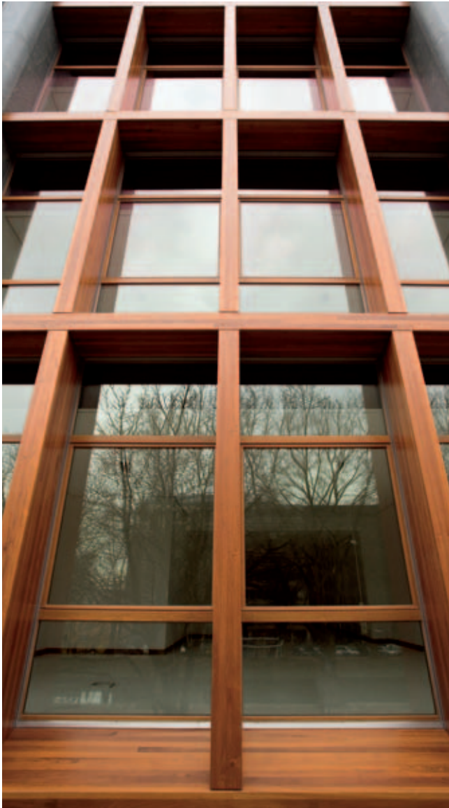
Die Stahlunterkonstruktion ist nicht sichtbar. Die Senkrechten und horizontalen Gliederungselemente wirken massiv.
