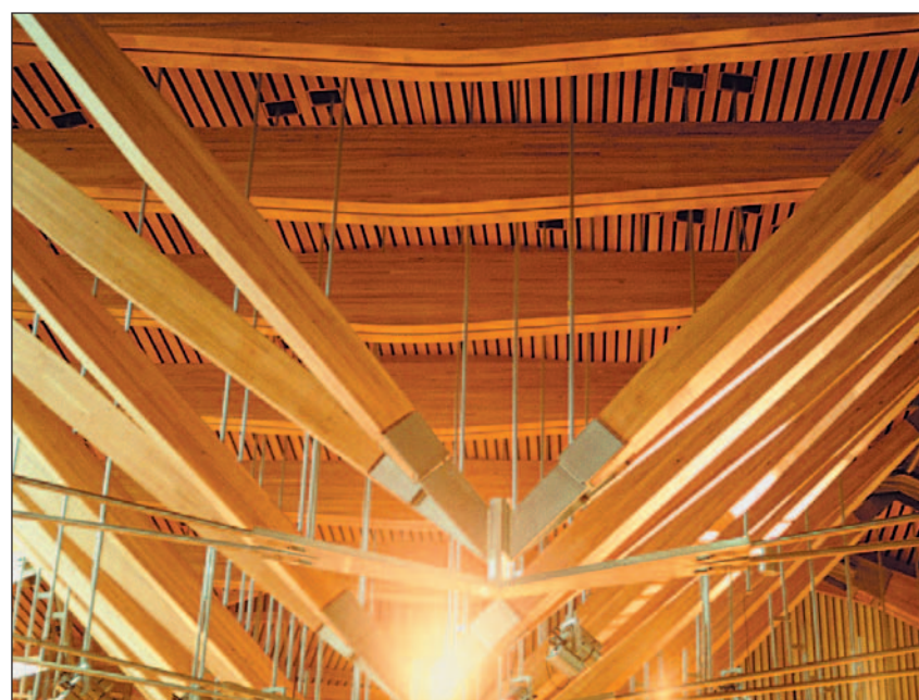
Eine beeindruckende Holzkonstruktion überspannt den Parlamentsraum – von außen nicht zu sehen.
