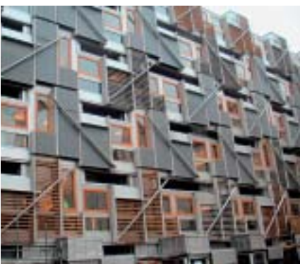
Lebendige Fassadenstruktur mit Fenstern aus Deutschland
