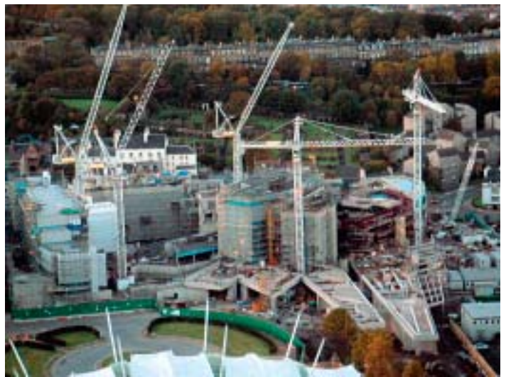
Hier entsteht das neue schottische Parlament
